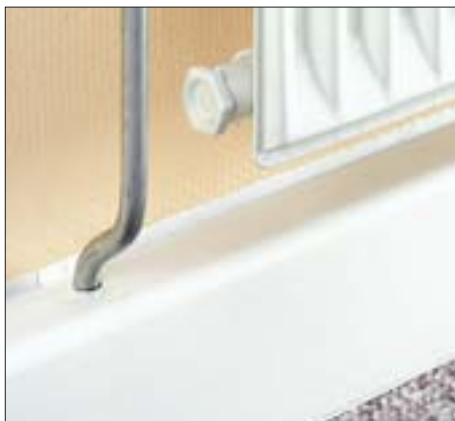
30. Selvklæbende roset placeres på panel ved stålørers-tilslutningen.
