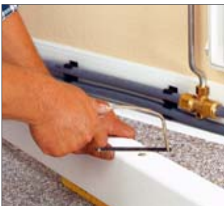
24. Udsækning til stålør-sæt bores og saves.
