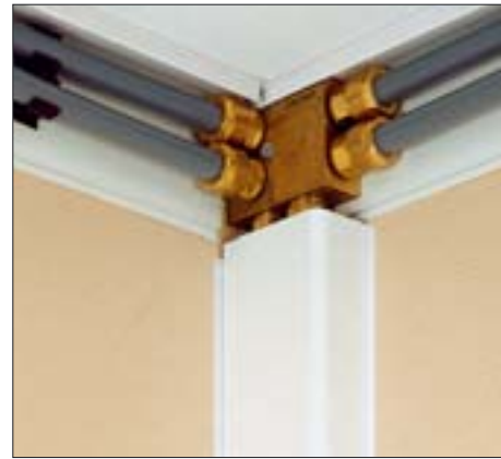
42. Colombusæg monteret i hjørne ved loft.
