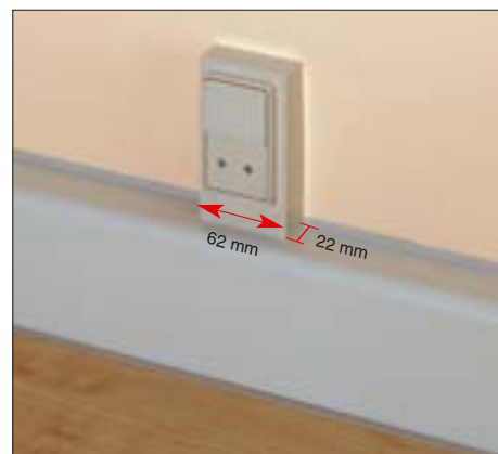
36. Der udskæres i frontpanelet, som monteres for færdig installation.
